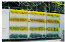
瘦俏型植物绿墙，厚度约10cm，薄型“花卉墙壁/瘦俏型”可实现无损外观绿化。使用垂吊植物、藤蔓植物可达到美化立面的效果，且更具灵活性，方便拆卸，无需专业人士指导。
